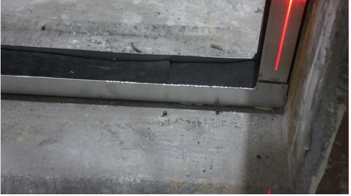
Şekil 3.3 Perspekta Sistem 10 mm Temperli Cam / 5 mm + 4 mm 1,52 A.PVB Lamine Cam Montaj Detayı
