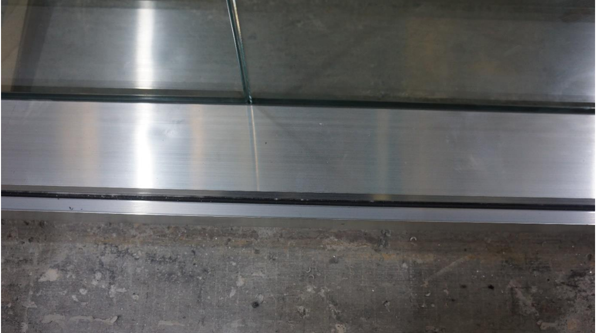
Şekil 3.6 Perspektik Sistem 10 mm Temperli Cam / 5 mm + 4 mm 1,52 A.PVB Lamine Cam Montaj Detayı 4
