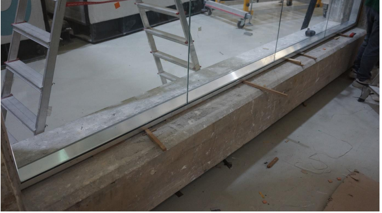
Şekil 3.5 Perspektik Sistem 10 mm Temperli Cam / 5 mm + 4 mm 1,52 A.PVB Lamine Cam Montaj Detayı 3
