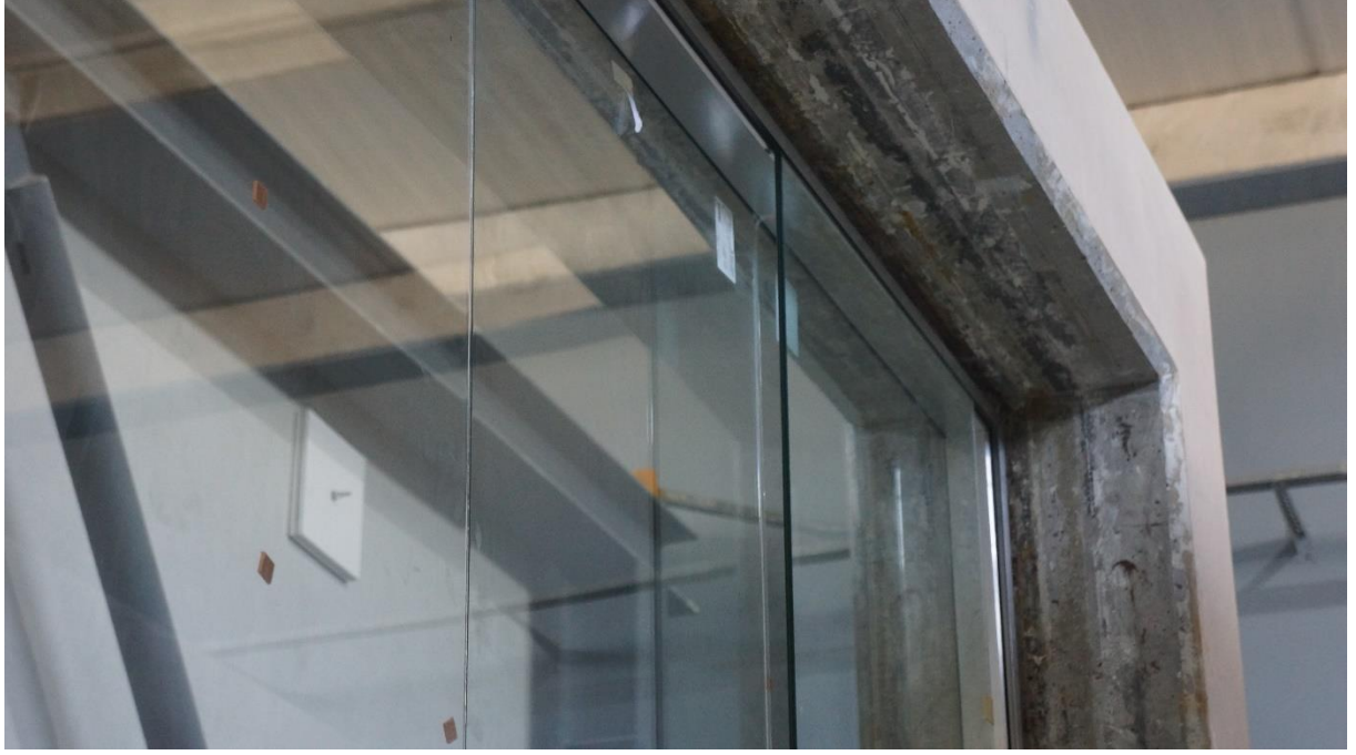
Şekil 3.7 Perspeka Sistem 10 mm Temperli Cam / 5 mm + 4 mm 1,52 A.PVB Lamine Cam Montaj Detayı 5
