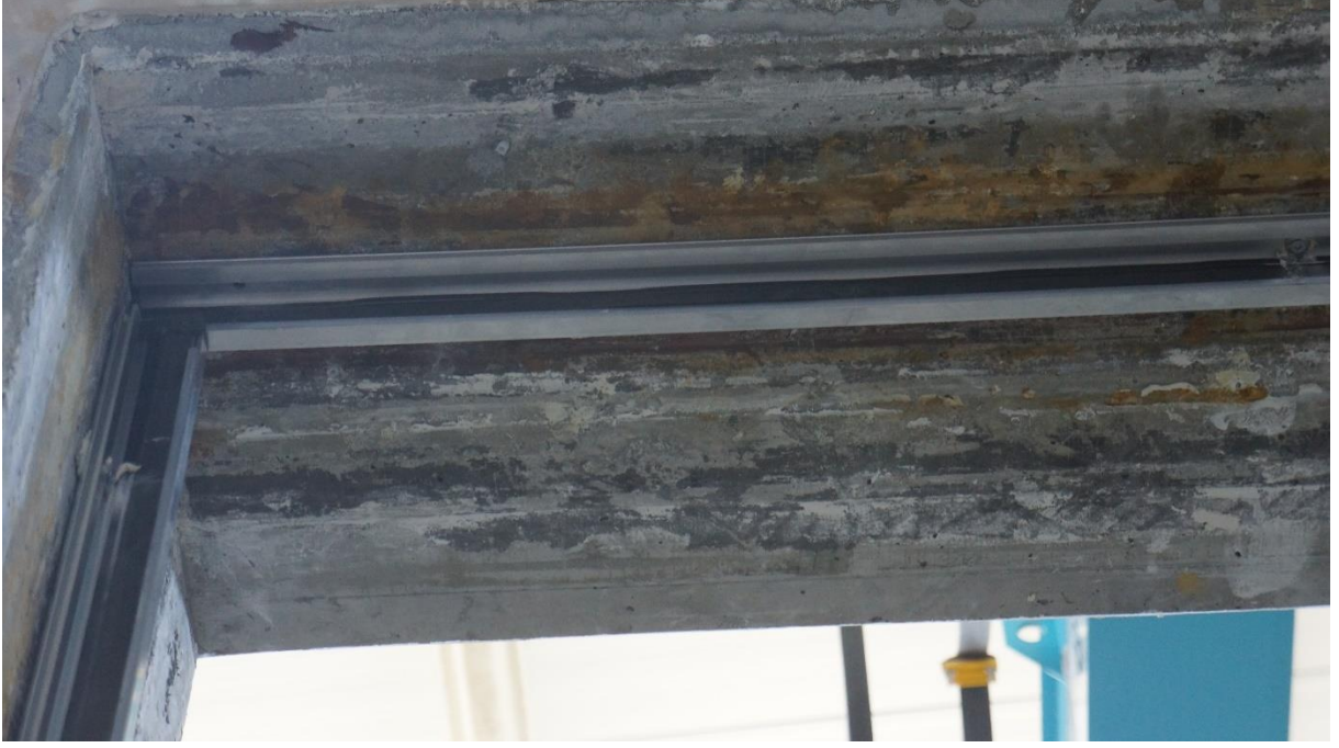
Şekil 3.3 Vera Sistem 5 mm + 4 mm 1,52 A.PVB Montaj Detayı
