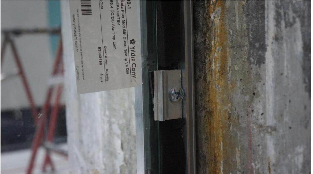
Şekil 3.6 Vera Sistem 5 mm + 4 mm 1,52 A.PVB Montaj Detayı 4
