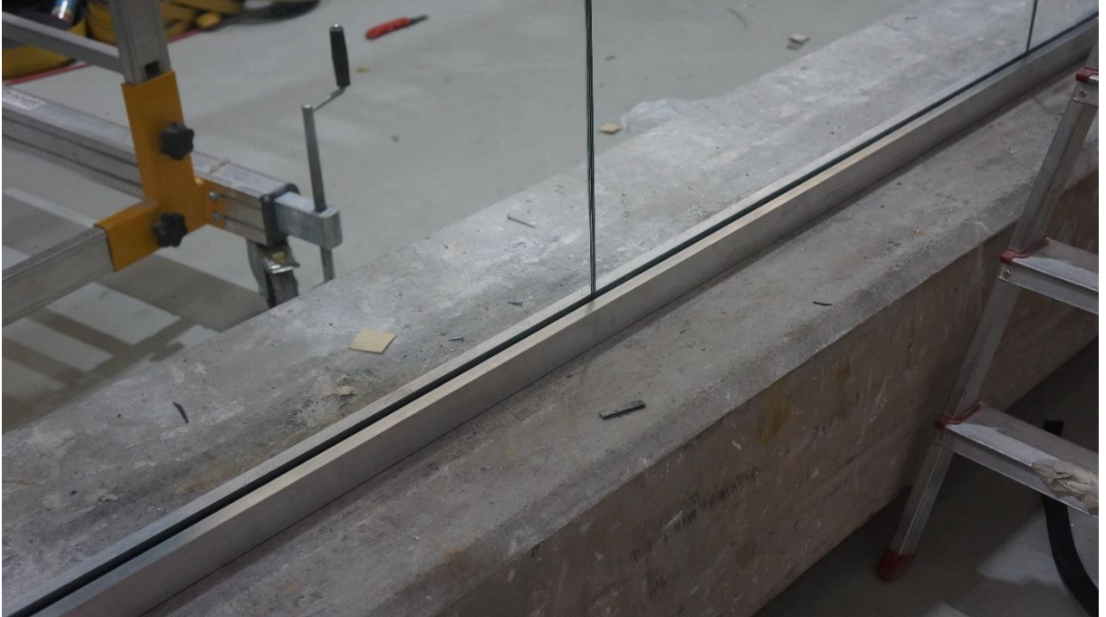
Şekil 3.4 Vera Sistem 5 mm + 4 mm 1,52 A.PVB Montaj Detayı 2
